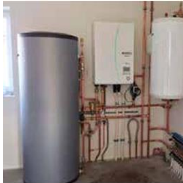
Voorbeeld van een hydrobox-opstelling met een 100 liter boiler en een buffer van 100 liter.
